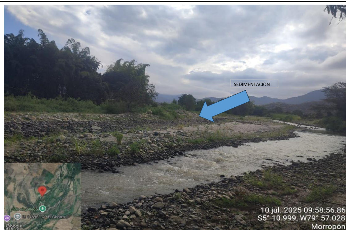
Figura N° 03: Se observa la colmatación en el cauce del río La Gallega obstruyendo ingreso del agua a la bocatoma Morropón Franco.
